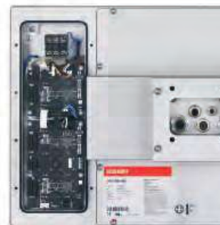
Open wiring space
