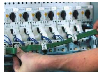
Надежная установка и электромонтаж
