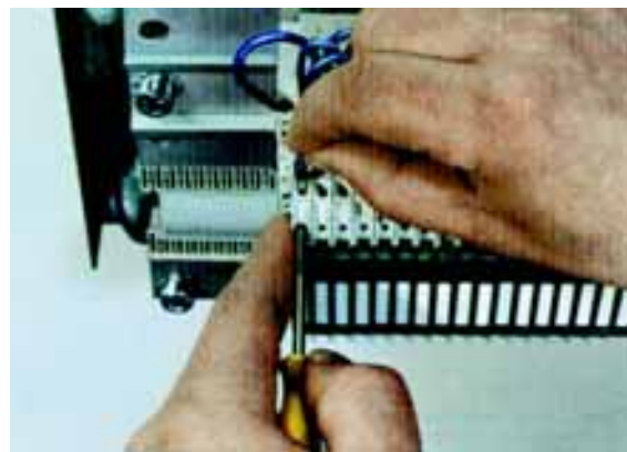
Подключение провода к пружинному контактному зажиму
